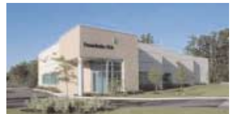
Gebäude des CCL, CLT und Headquarters von Fraunhofer USA in Plymouth
