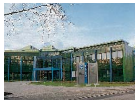
Gebäude des Dortmunder OberflächenCentrums
